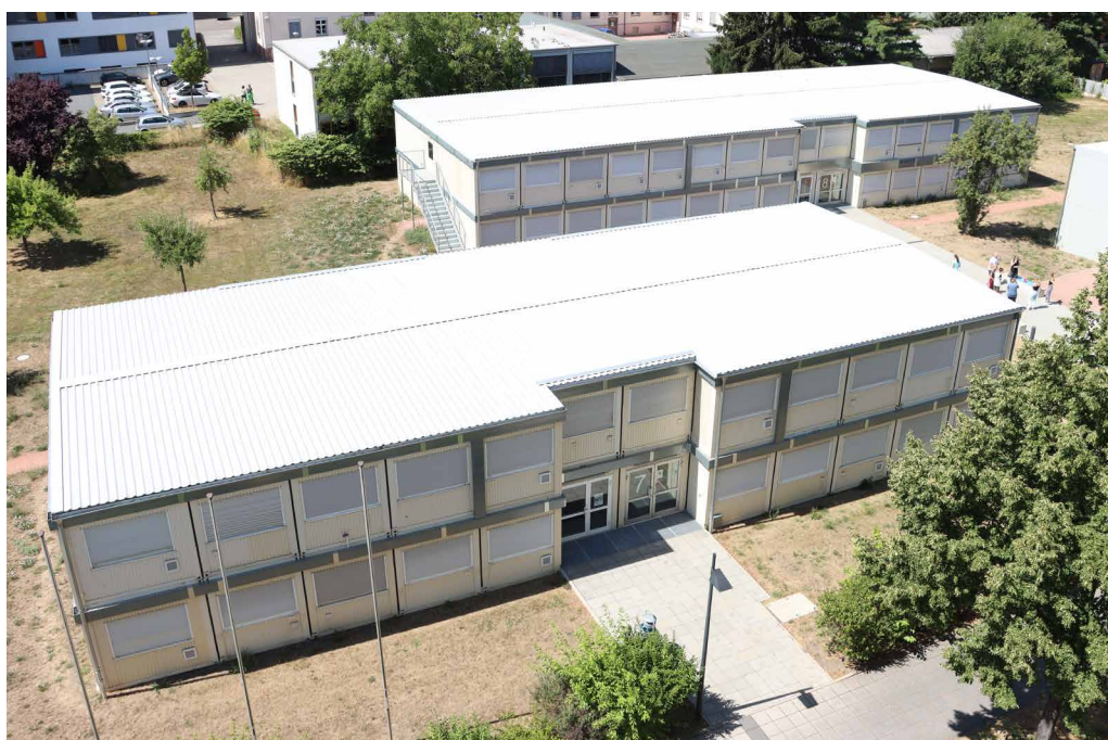
Modulbauten Haus 7 und Haus 8 auf dem Campus der HSF Meißen
