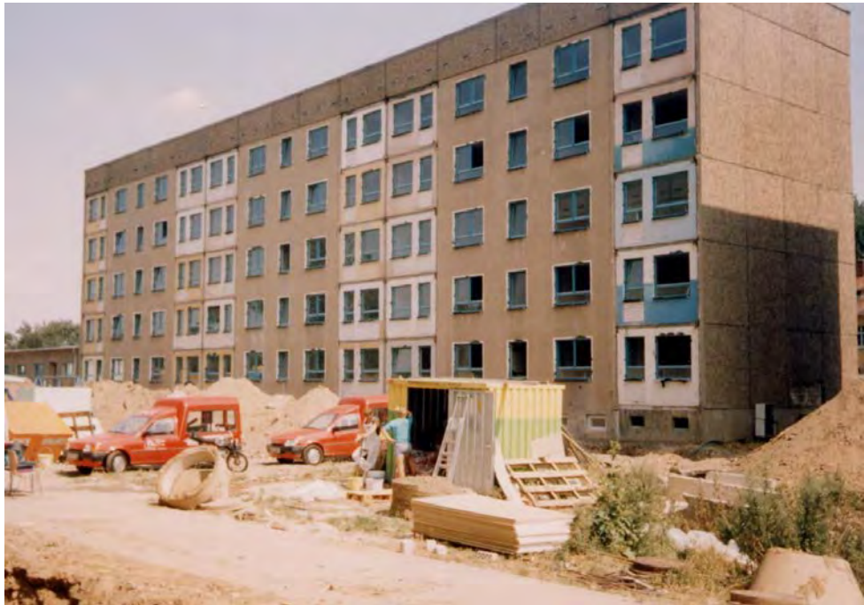
Sanierung Haus 1, Meißen-Bohnitzsch
