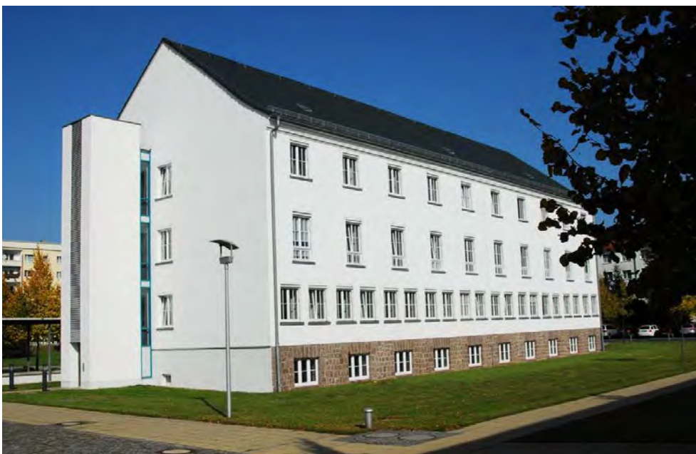
Haus 2, Lehrsaalgebäude für die Fortbildung
