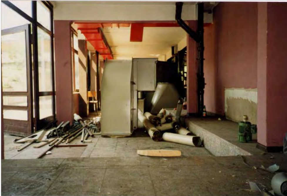
Sanierung Haus 3, Herbert Böhme Straße
