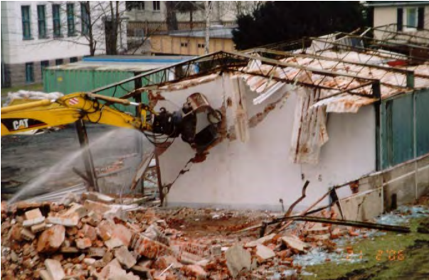
Abriss der Laborhalle
