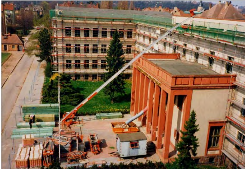
Sanierung Haus 1, Herbert Böhme Straße
