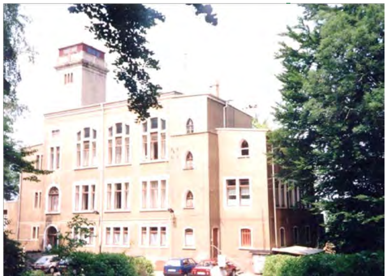
Ausweichobjekt Wohnheim Cossebaude „Osterburg“
