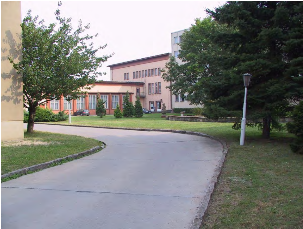
Mensa und Verwaltungsgebäude der Liegenschaft Riesa
