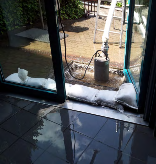
Aufsteigendes Grundwasser im Haus 1 wird abgepumpt
