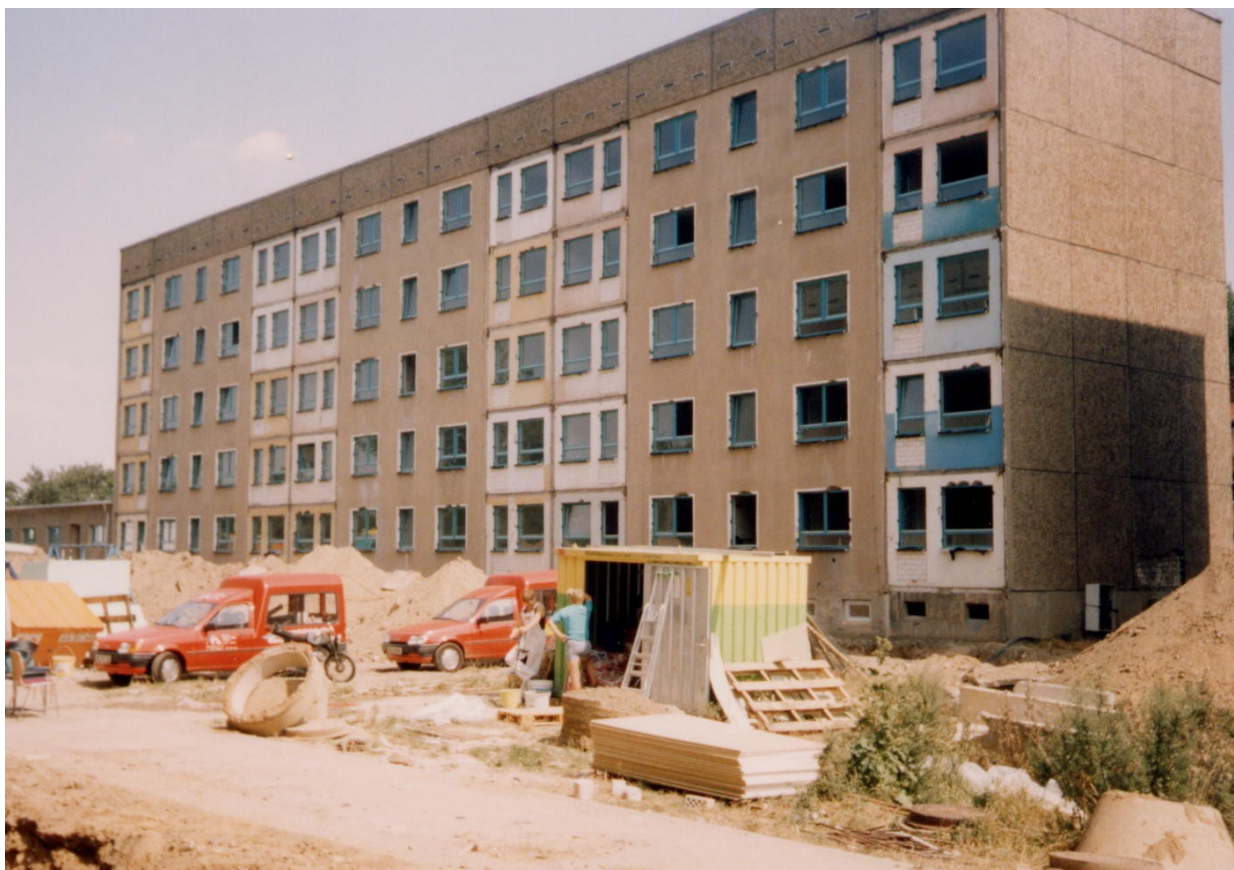
Sanierung Haus 1, Meißen-Bohnitzsch
