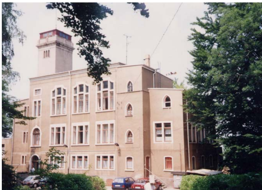
Ausweichobjekt Wohnheim Cossebaude „Osterburg“
