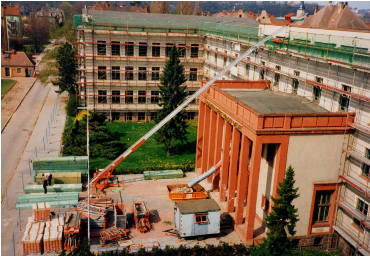
Sanierung Haus 1, HBS
