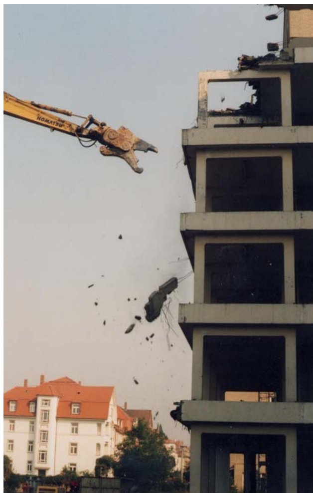
Außensanierung Haus 3, HBS Abbruch der Balkone
