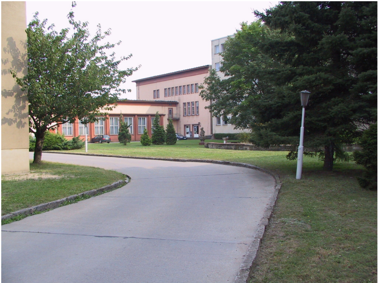
Mensa und Verwaltungsgebäude der Liegenschaft Riesa
