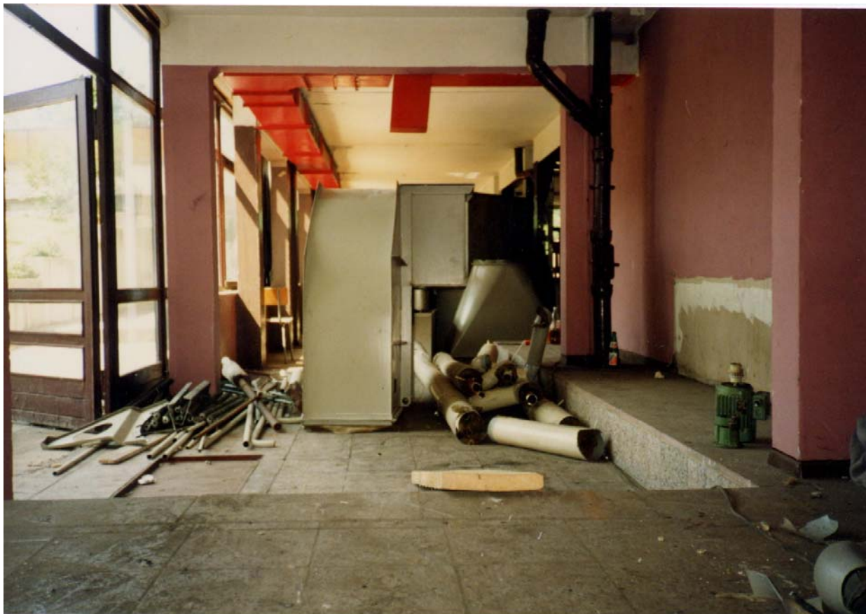
Sanierung Haus 3, HBS
